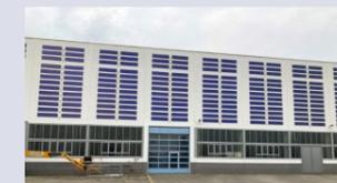
Die innovativen Solarfolien basieren auf einer neuartigen Solartechnologie und ermöglichen dank ihrer Leichtigkeit und Flexibilität Solarstromerzeugung genau auf den Flächen, wo konventionelle Solarlösungen aufgrund unzureichender Dachstatik oder unpassender Dachkonstruktionen nicht praktikabel sind. Diese, organische, Solartechnologie ist die sauberste aller Solartechnologien und ist ein wichtiger Schritt in Richtung einer CO<sub>2</sub>-neutralen Zukunft.
