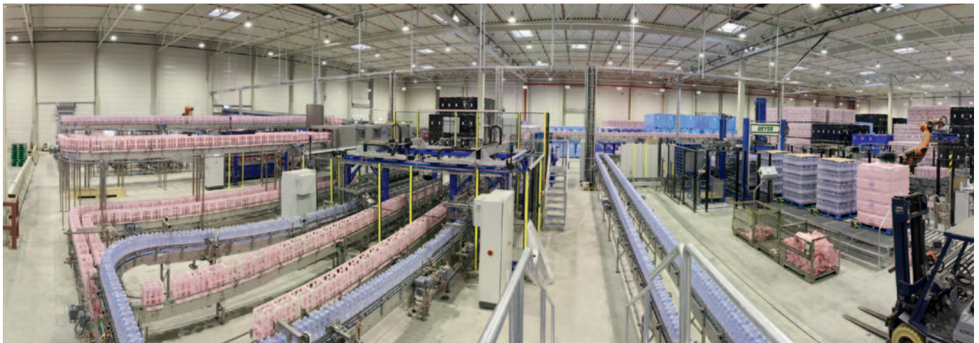
Die Umpackanlage für Mineralwasserflaschen bildet das Herzstück der Logistikhallen im Duisburger Hafen.
