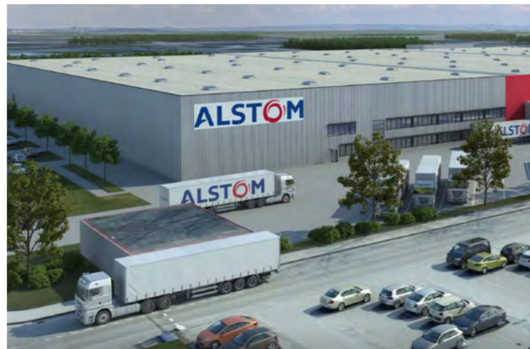
Im Frühjahr 2015 soll das neue Logistikzentrum mit 30.000 Quadratmetern Hallenfläche den Betrieb aufnehmen und die Produktionsstätten von Alstom mit Komponenten versorgen.
